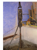
Pålning och grundförstärkningar.
