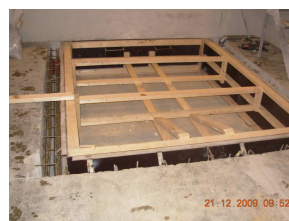
Armering och betongarbeten. Här med en pumpgrop för dränering
