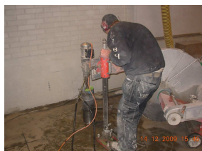
Sågning och håltagning i betong.
