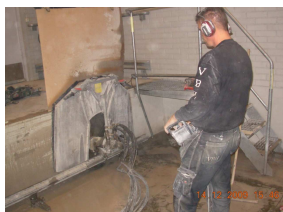
Sågning och håltagning i betong.
