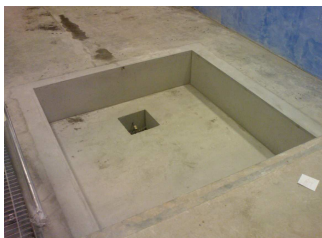
I den färdiga gropan görs sedan montage och elinstallationer.
