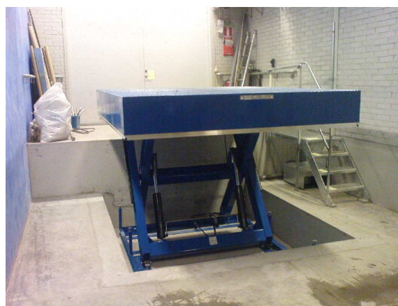
I den färdiga gropan görs sedan montage och elinstallationer.
