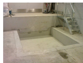
Armering och betongarbeten. Här med en pumpgrop för dränering
