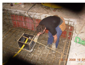
Armering och betongarbeten. Här med en pumpgrop för dränering
